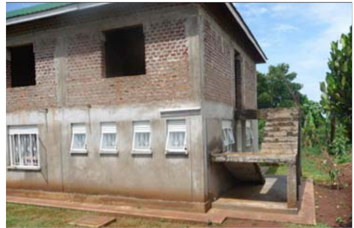
Noch fehlt das Geld: Das Untergeschoss des Mädchenheims ist fertig. Für den Ausbau des Obergeschosses fehlen aber noch einige tausend Euro.
